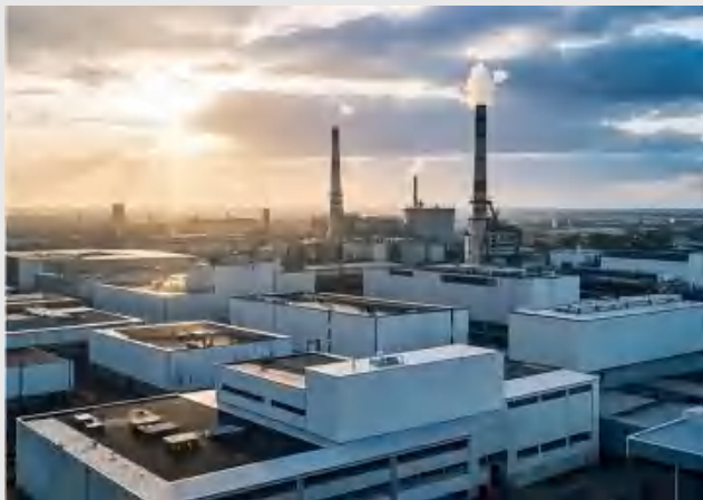
工业园区（削峰填谷）
